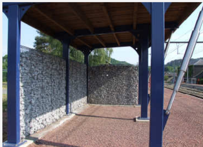
Abri quai 1 (vers Jemelle) : les parois sont constituées de gabions d'épaisseur réduite et de hauteur limitée
