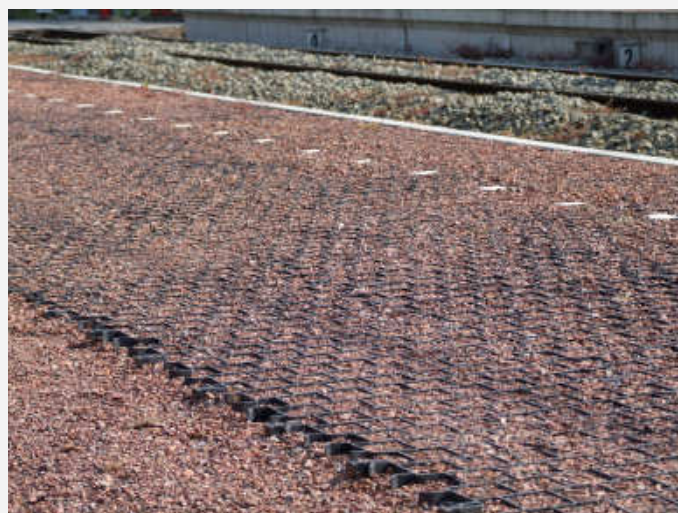
Localement affouillés, les treillis peuvent provoquer des chutes
