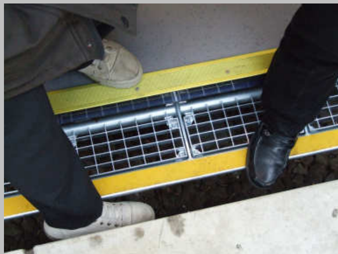
L'espace entre le marche-pied et le quai atteint 12cm et le rôle de pare-chute est compromis
