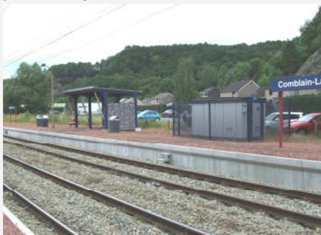
Quai 1 (vers Jemelle) à gauche l'abri, à droite l'armoire électrique sous
