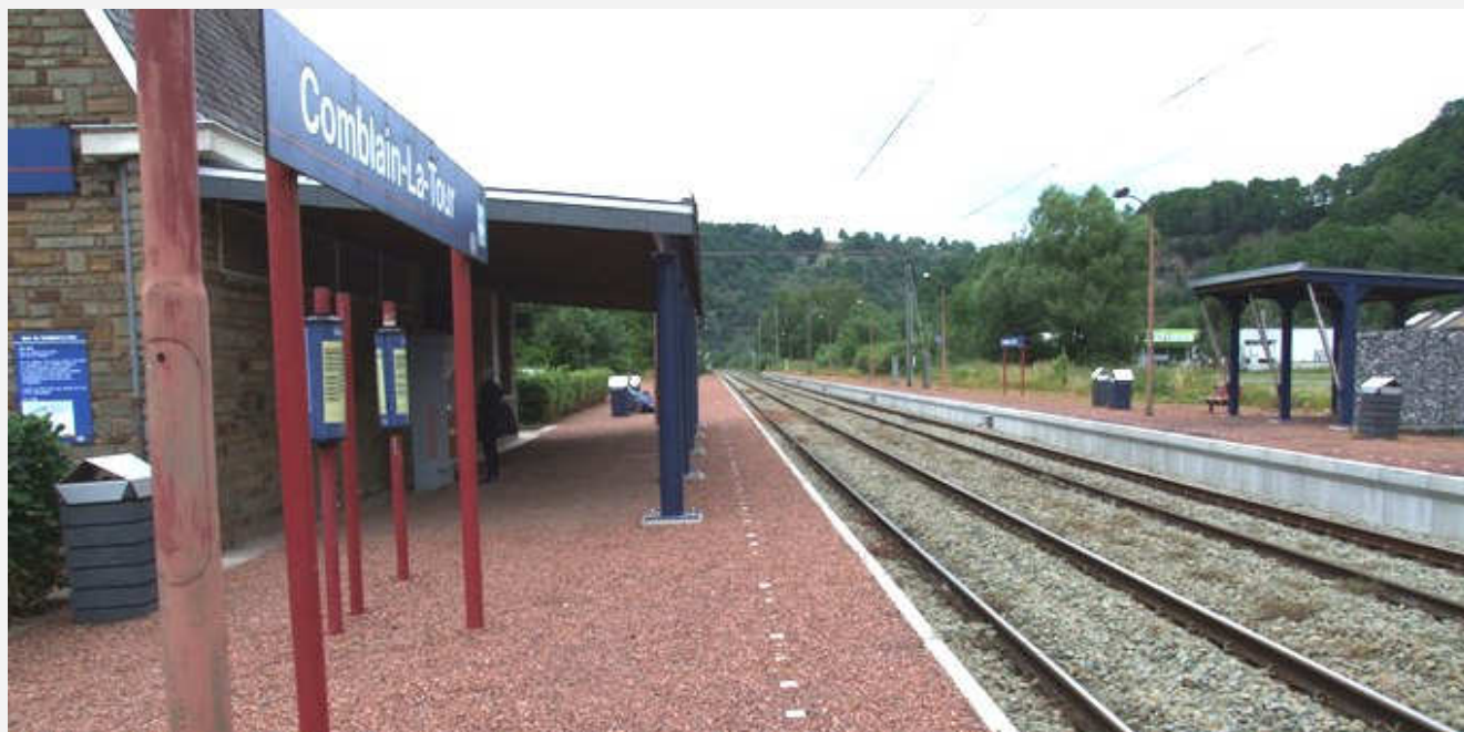
Vue générale du pang de Comblain-la-Tour, avec quais rehaussés et lignes de sécurité
