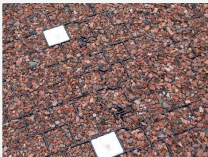
Les plots sont attachés à un treillis métallique déroulé sur le sol
